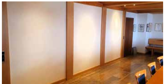
„Lehmputz statt Jute“ – der erste Schritt ist vollzogen
