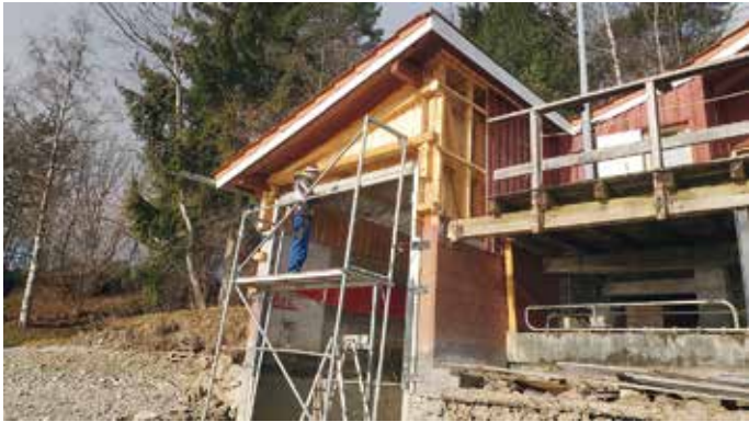
Rückbau Schild und Ausbau Garagentor
