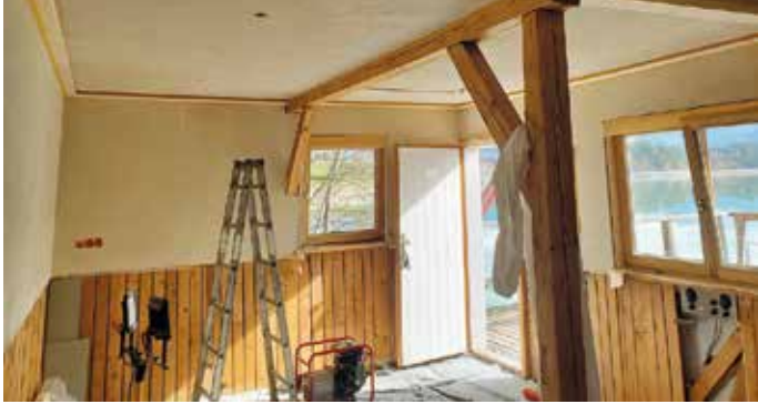
Abgeschlossene Grundierungsarbeiten für das Verputzen
